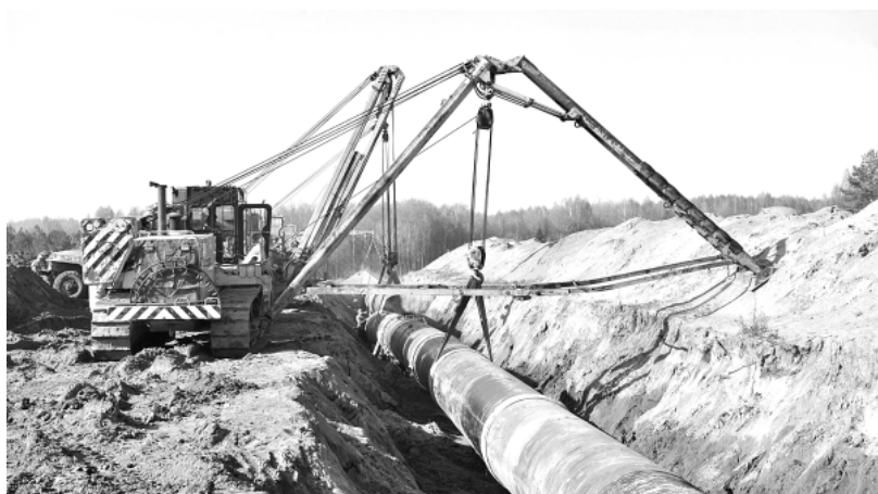
На трассе идут работы.
