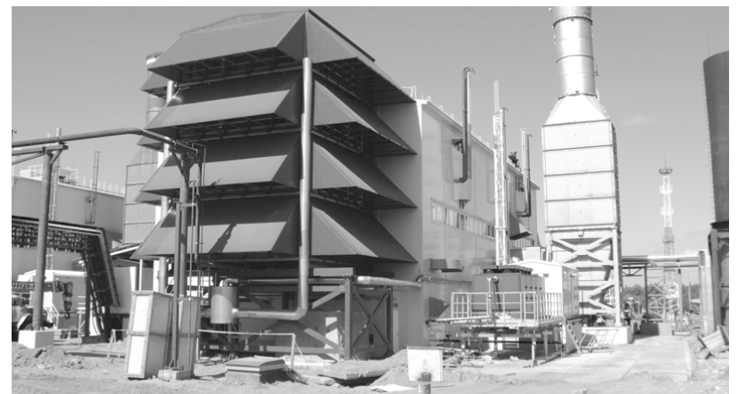
Строительство второго ГПА-32 «Ладога» на КС «Вавожская».
