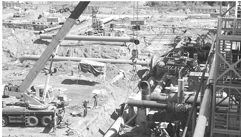
Капитальный ремонт технологических трубопроводов на компрессорном цехе.
