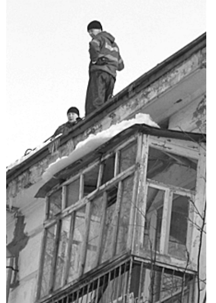
На одной из крыш все же идут работы по ликвидации сосулек и снега.
