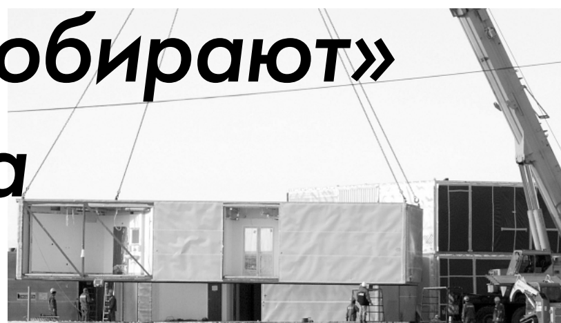
Каждый модуль – готовая палата, «начиненная» коммуникациями и сантехникой. Вес такого модуля – от 4 до 39 тонн.
